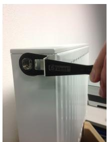
Montieren Sie der Körper den dauerhaften Entlüfter ECO (S-Vent Duo) in den Heizkörper, benutzen Sie hier für bitte den eigens dafür lieferbaren S-Vent DUO Montageschlüssel (Artikelnummer T2151), benutzen Sie auf gar keinen Fall eine Wasserpumpenzange o.ä.
