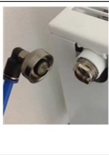
Zur schnellen und gründlichen Handentlüftung öffnen Sie bitte wieder den Vor- und Rücklauf des Heizkörpers und schrauben Sie den Entleerungsschlauch (Artikelnummer T2152) auf den im Heizkörper montierten Entlüfter.
