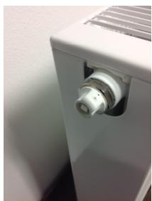
Demontieren Sie zuerst den werkseitig vormontierten Entlüftungsstopfen.
