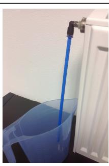
Während des Entlüftungsvorganges empfehlen wir das austretende Luft-Wassergemisch in einen dafür geeigneten Behälter abzuleiten.
