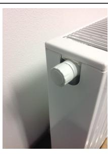
**Achtung :** Nach der Handentlüftung drehen Sie den Membrane Deckel auf den Entlüfter, die permanente Entlüftung des Heizkörpers ist nun aktiviert.
